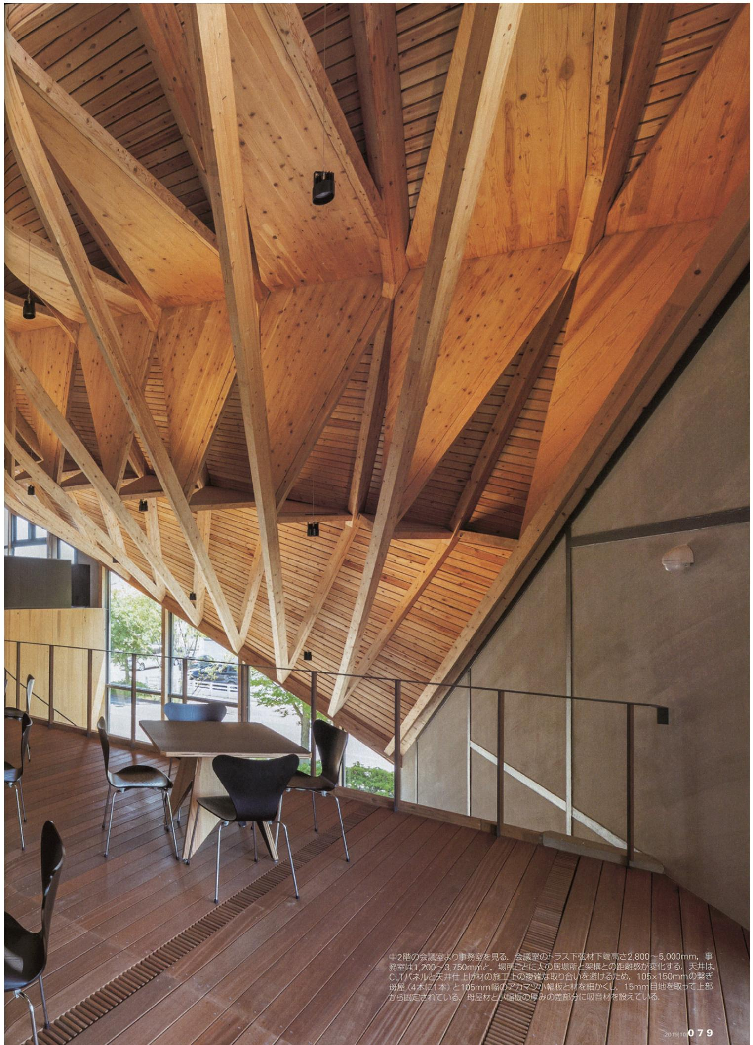
中2階の会議室より事務室を見る。会議室のトラス下弦材下端高さ2,800～5,000mm、事務室は1,200～3,750mmと、場所ごとに人の居場所と架構との距離感が変化する。天井は、CLTパネルと天井仕上げ材の施工上の複雑な取り合いを避けるため、105×150mmの繋ぎ枋屋(4本に1本)と105mm幅のアカマツ小幅板と材を細かくし、15mm目地を取って上部から固定されている。母屋材と小幅板の厚みの差部分に吸音材を設えている。
