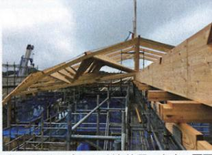
左上：平面トラス地組み風景。ビスにはシネジック社製のバナリードを使用。右上：平面トラス間をCLTで繋結する。左下：トラス上弦材を母屋と小幅板で繋ぐ。右下：平面トラスの真東下端位置に仮梁が架かる。
