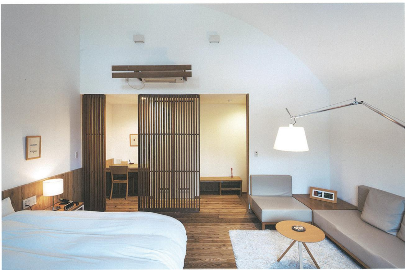
右頁写真／304室。最上階の小屋高を室構成に生かす。室内は漆喰塗りとし、やわらかな光の空間に落ち着きを得たいと曲面の天井とした。窓は既成の縦滑り出しアルミサッシを用い、両袖に小格子戸を付けて通風を取り景色のグレアを防ぐ働きを持たせた
