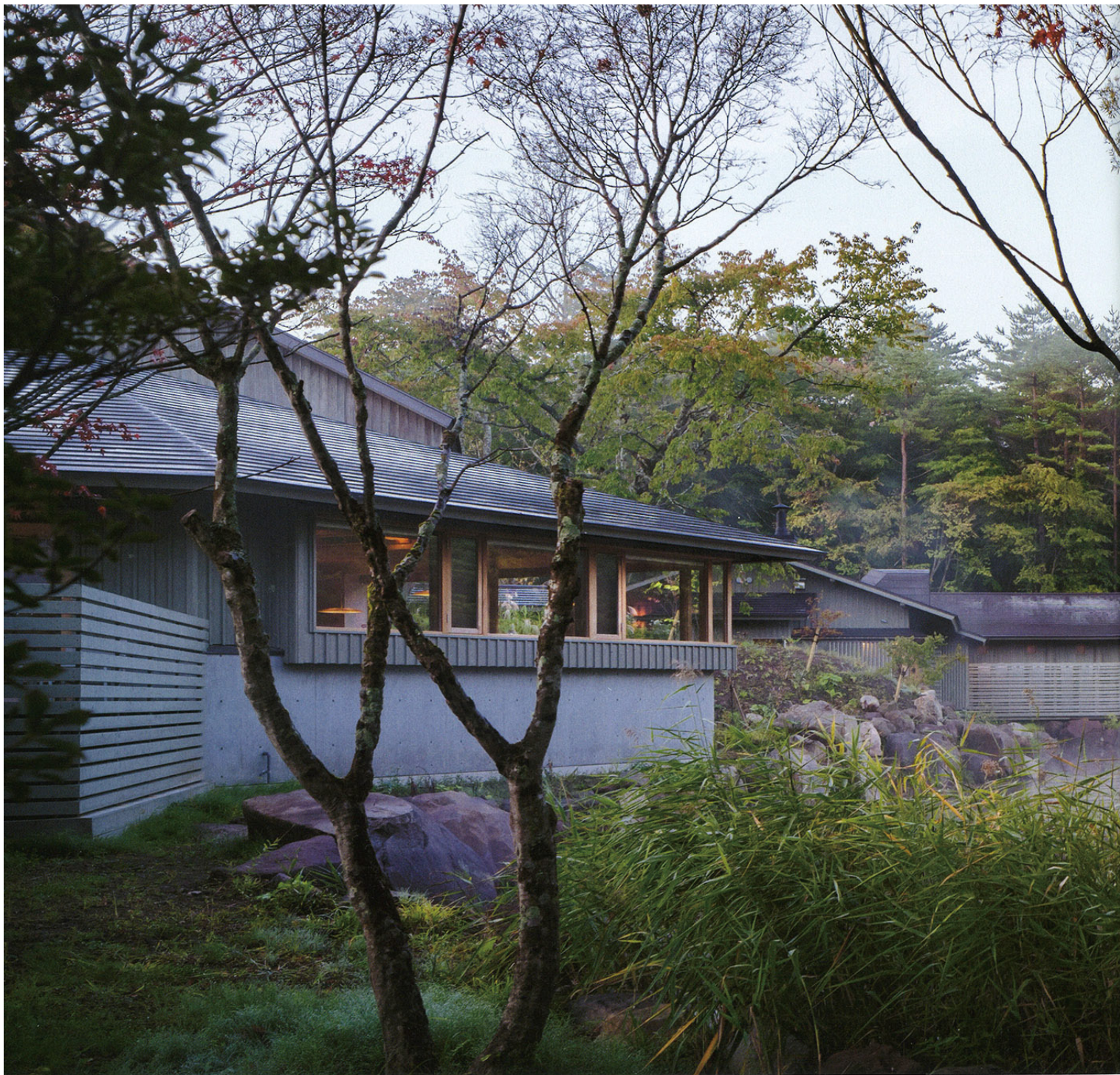
北側よりラウンジ棟越しに客室棟を見る。敷地造成を一切せずに、既存施設および環境とを繋ぐように、2棟が増築された。
