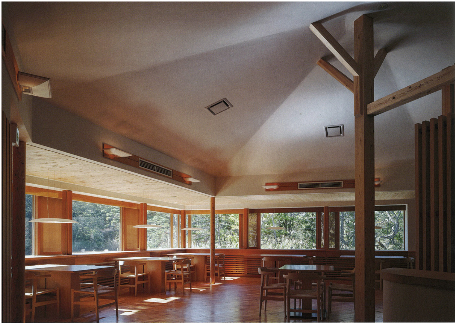
ラウンジは、食堂専用の本館のレストランに対して、会合や飲食等、多目的にも使えるスペースとして設けられた。屋根架構を中央の柱に寄せる寄棟の形式としている。
