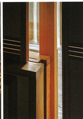
左：ラウンジ棟の照明はオリジナルデザインで、テーブルのペンダントは窓外の眺望を損なわないように薄いシルエット形状にした。中：廊下に設けた照明（詳細は本頁上）。右：開口部の納まり（詳細は121頁上）。遮光戸を開いた時に戸が重なるようにした欠き込み。
