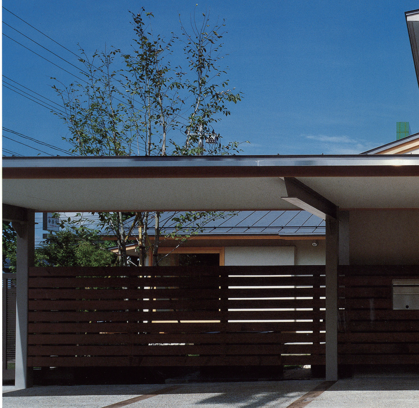
玄関のある東側外観全景／2階の煙突脇には、朝日を室内に入れる窓を設けている
