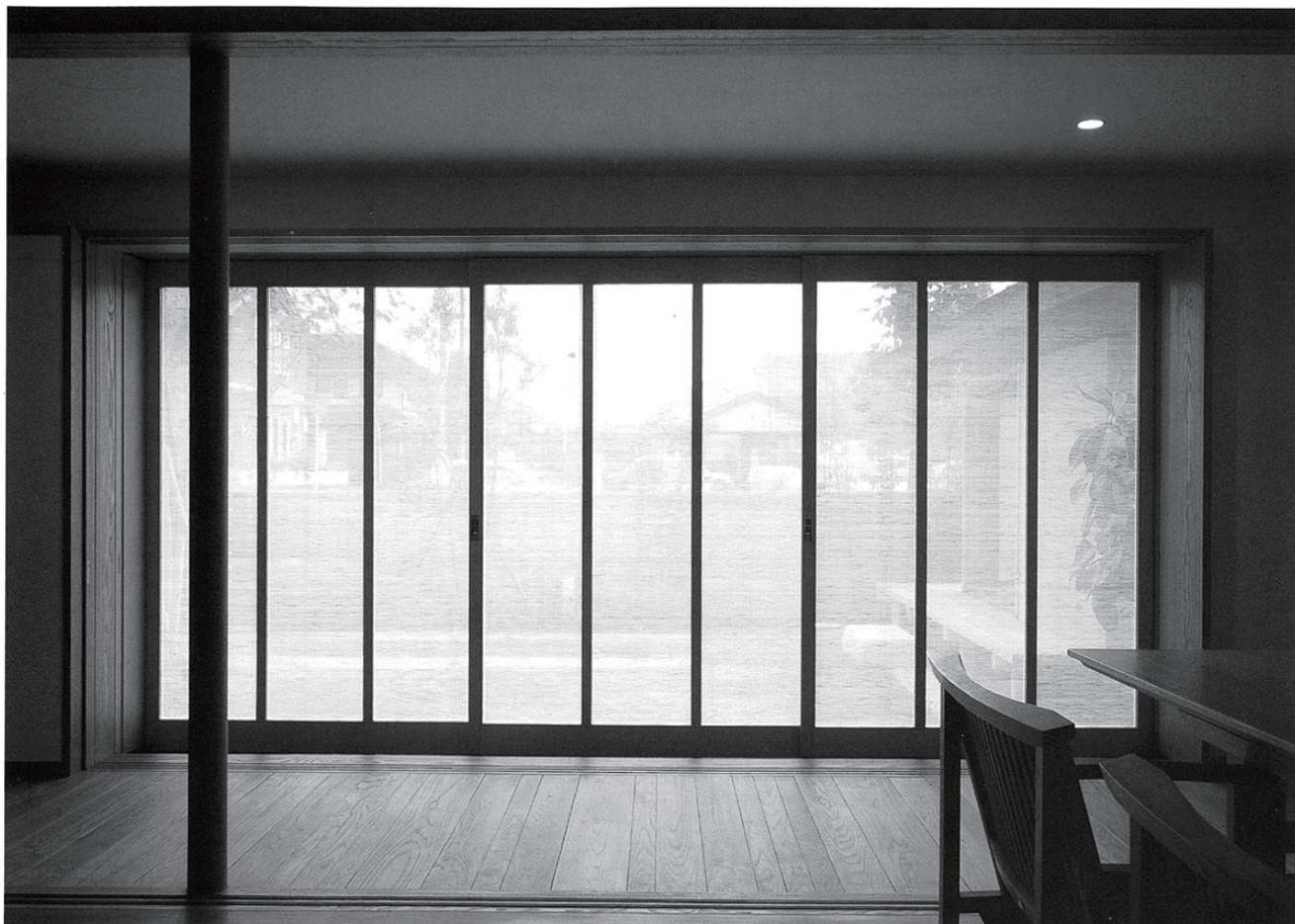
南縁スペース／夏用のスタレ（ヒバ製の枠に竹をはめ込んだ）を閉めた状態
