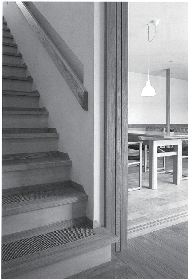
床、階段、仕切り戸、敷居廻り
