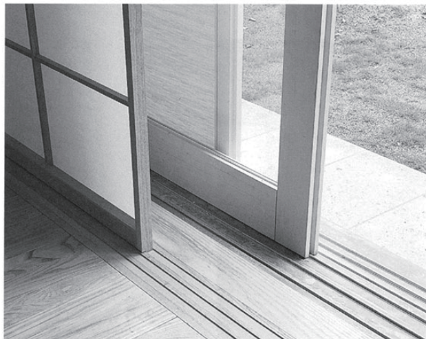
建具の構成／内側から障子戸（枠＝タモ）、ガラス戸（枠＝ヒバ）、スタレ戸
