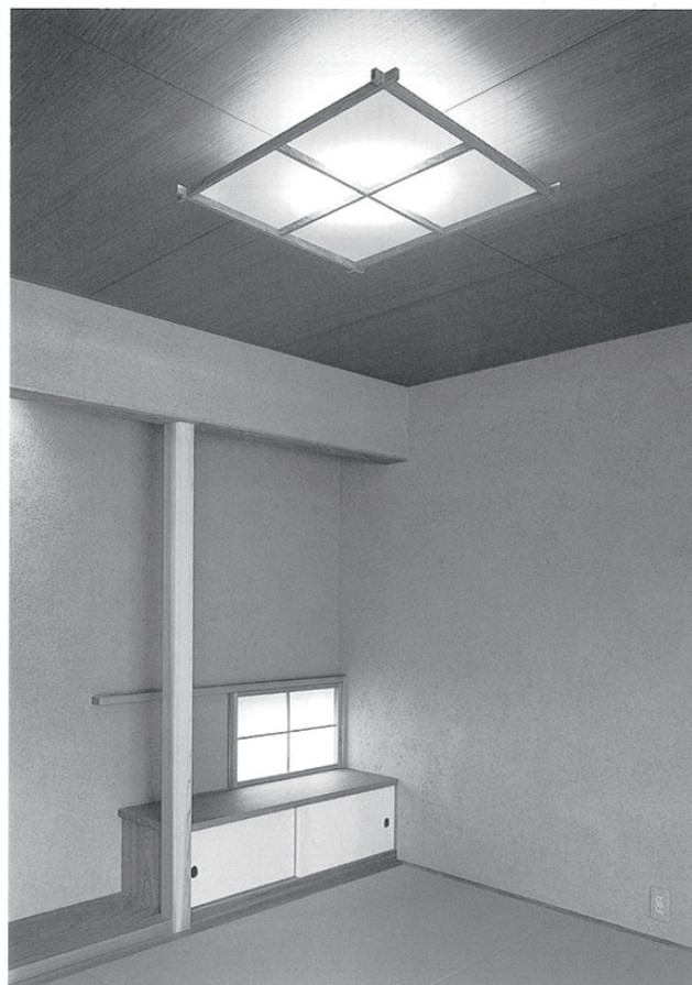
右頁写真：東と南の二方向に濡縁を設けた離れ和室 上写真：和室北面／天井はタモ合板目透かし張り 下写真：和室床廻り／天井には、障子をアレンジしたオリジナルデザインの照明
