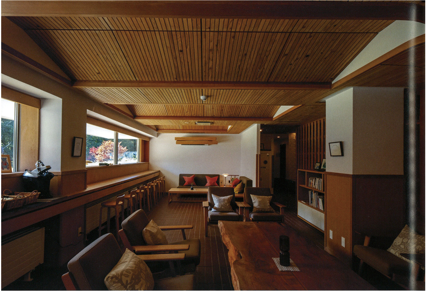
元は地下倉庫だった本館ラウンジスペース。天井高が低かったため、梁のない箇所を折り上げるようにデザインした。
